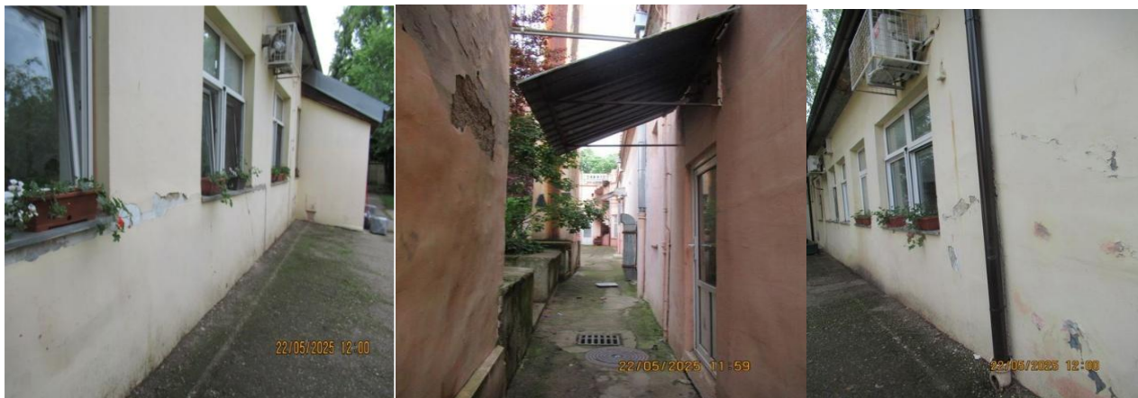
Фасаде појединих објеката
