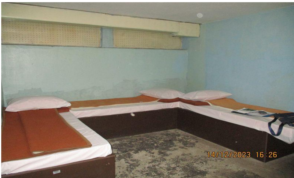
просторија за задржавање у ПС Прибој
